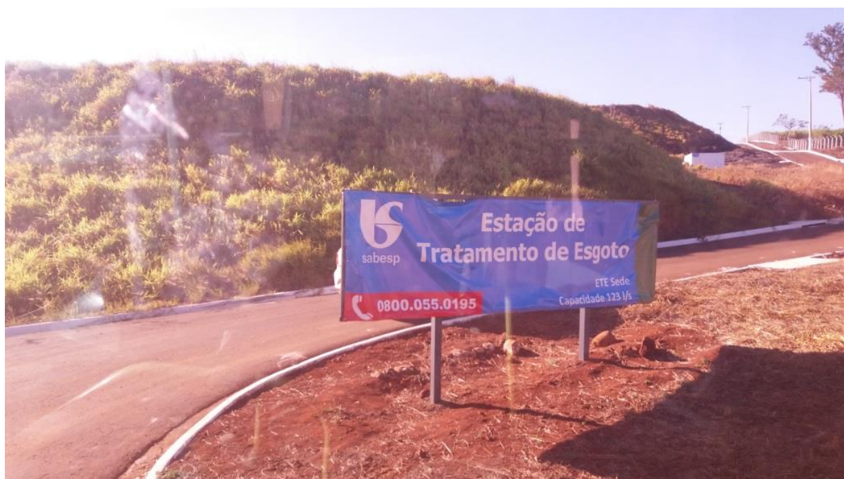
Imagem 1: Entrada da ETE localizada em Pederneiras.
